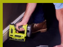
Sous-couche de sol
