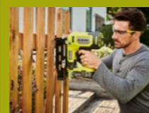
Réparation de clôture
